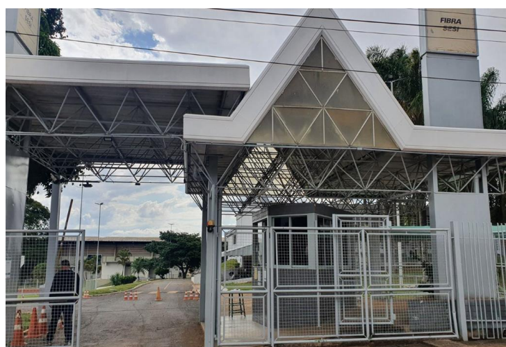
Figura 4-Retirada do chapéu "V" invertido.
